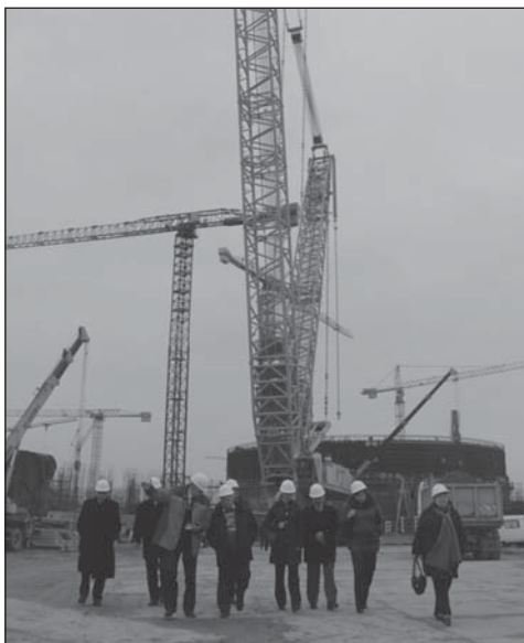
На фото изображена площадка монтажа ловушки реактора первого блока АЭС.
